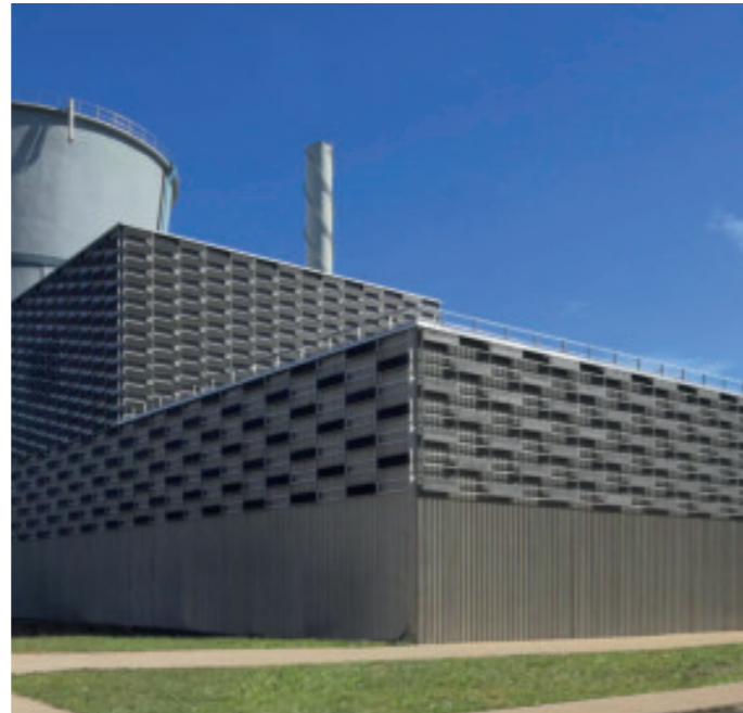
Accoya-Fassadenplatten beschichtet mit TEKNOL AQUA und NORDICA EKO
