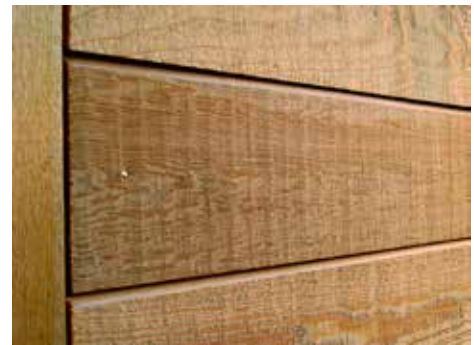
Afbeelding 1. Voorbeeld open gevelbekleding.
