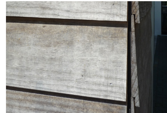
Les surfaces rugueuses sciées sont plus propices à l'accumulation
