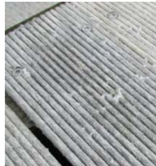
8.4 Fasern können sich in gerippten Oberflächenprofilen verfangen
