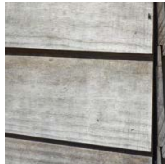
Raue gesägte Oberflächen sind der Aufbauschicht zuträglicher
