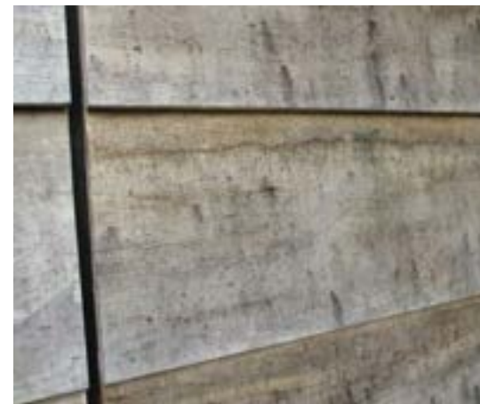
Raue gesägte Oberflächen sind der Aufbauschicht zuträglicher
